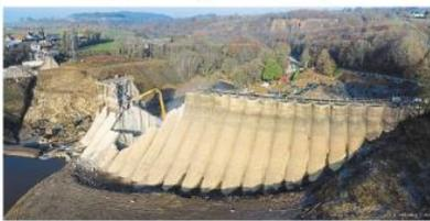
Décembre 2019 : les engins de démolition sont à l'œuvre et grignotent le béton des voûtes à contrefort du barrage de Vezins. (Photo: DOMMEX)
